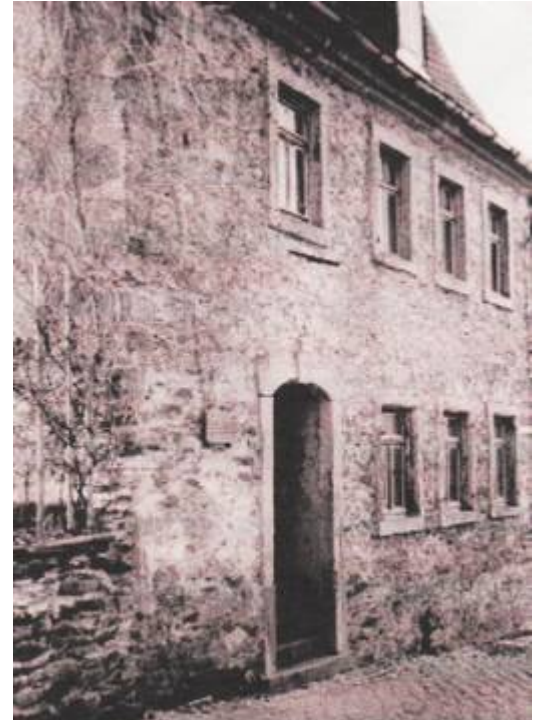
Der Eingang vom „Schumann-Haus“ in der Kirch-gasse Foto: Sachse
